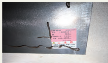
東邦亜鉛製: ソフトカーム 鉛 0.3mm 石膏ボード 12.5mm
