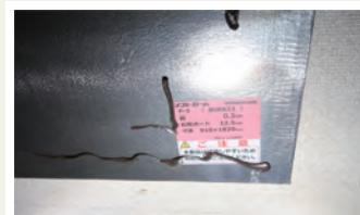
東邦亜鉛製: ソフトカム 鉛 0.3mm 石膏ボード 12.5mm
