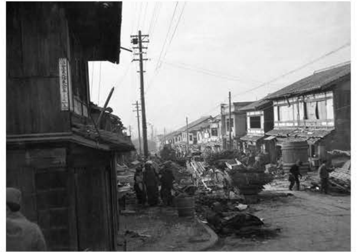
がれきの撤去作業が行われる渋谷通。復旧作業にあたる女性や大八車が映っている(村中秀光氏撮影、村中修氏所蔵、京都女子大提供)
